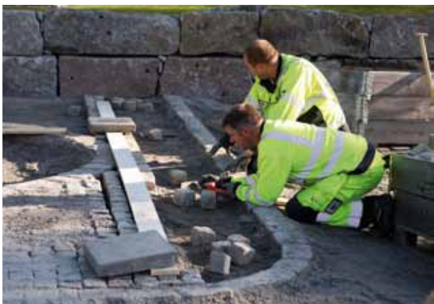
Ombyggnad av Kyrkparkeringen. Det gamla Piteå där tre historiska objekt Bogårdsmuren, Oskars källa och Repslagarbanan skall införlivas i sittmiljöerna FOTO:TORE SUNDSTRÖM
